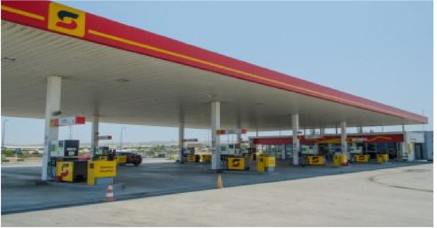
Station-service du Catumbela
