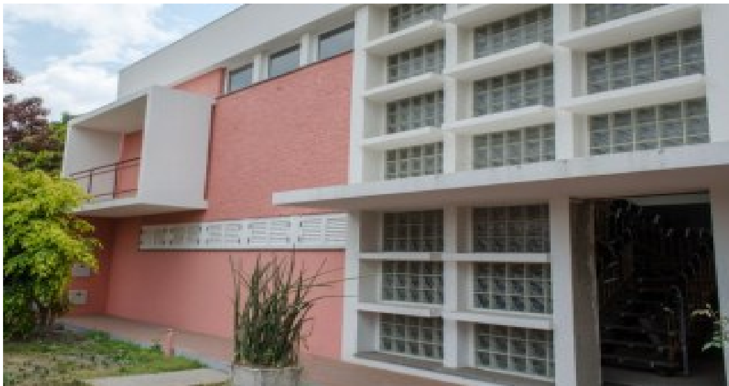
Casa Privada Kuito
