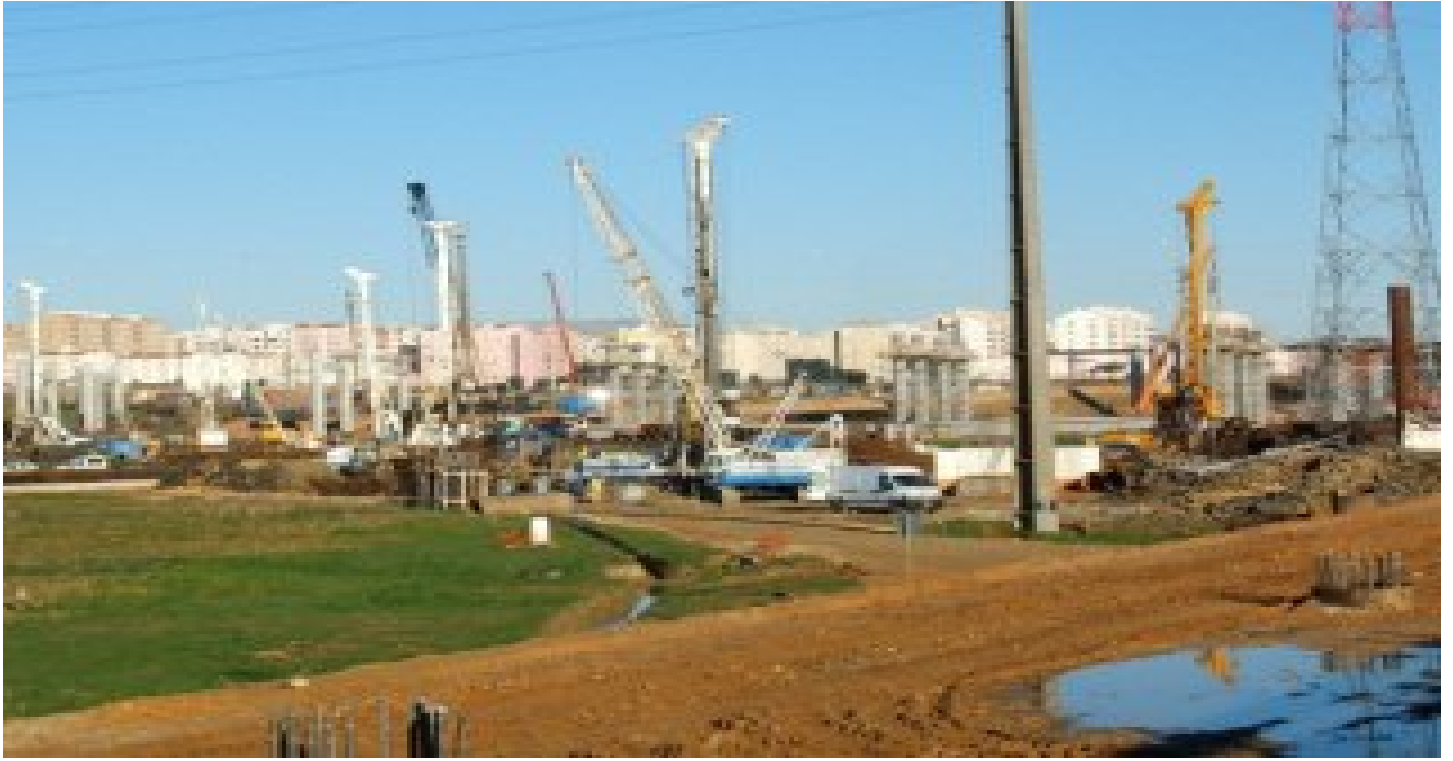
A10 - Carregado Interchange
