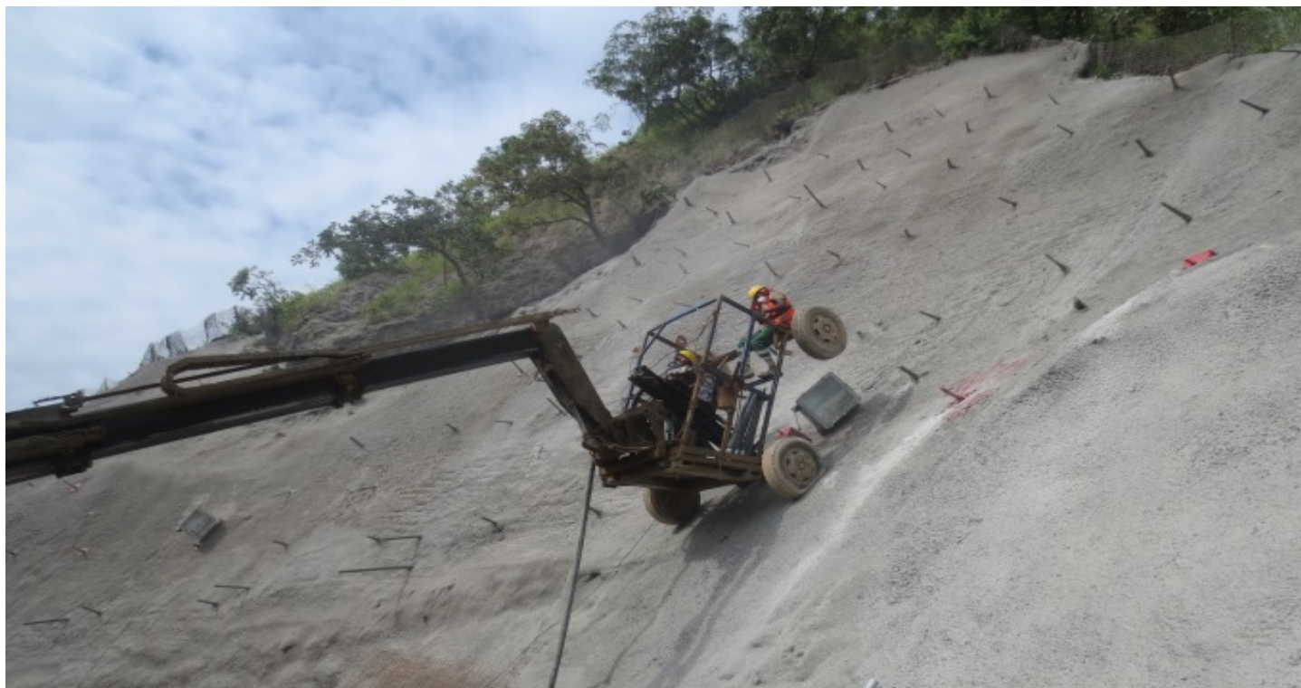
Barragem de Lauca
