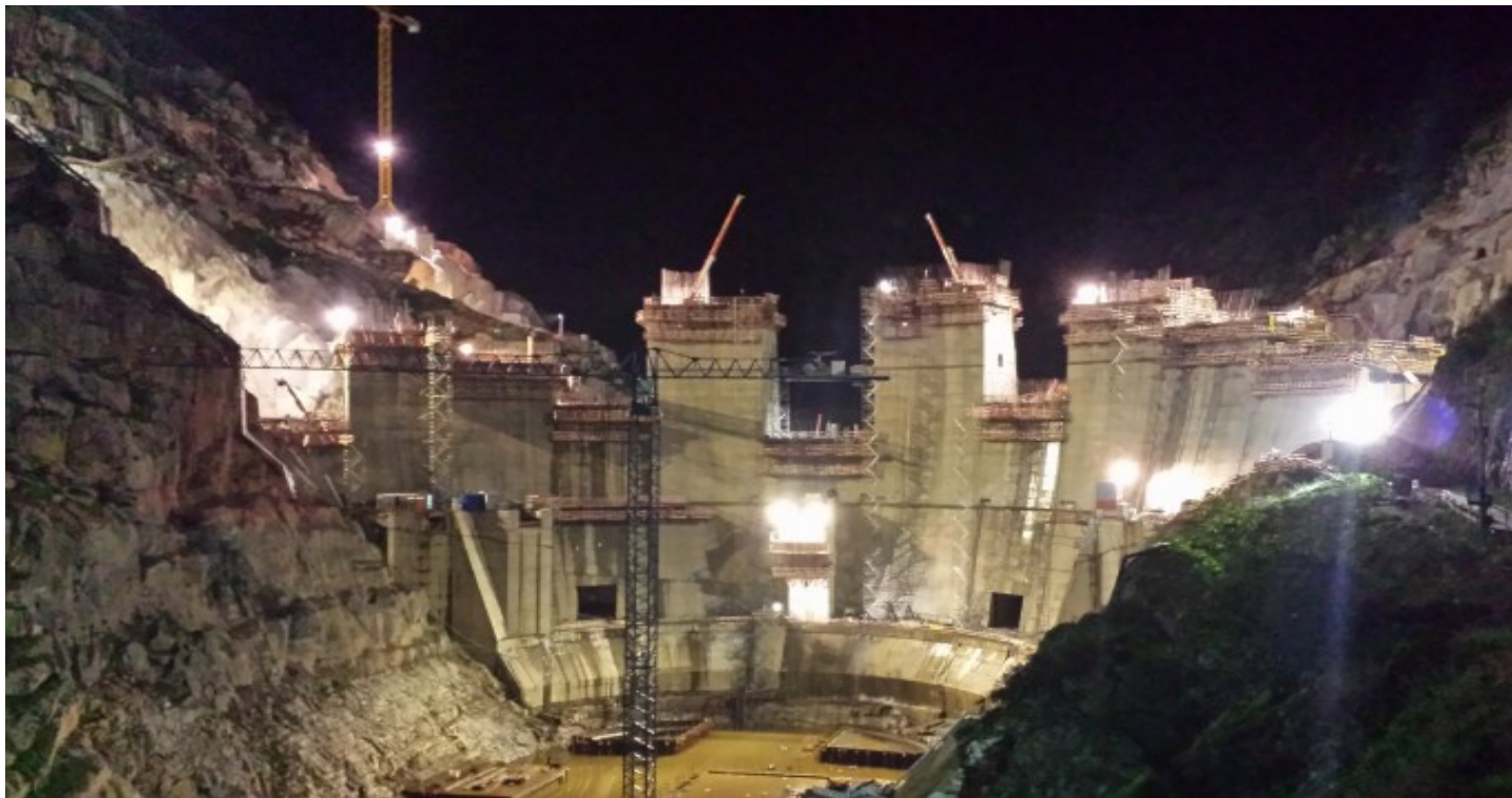
Barragem de Foz Tua
