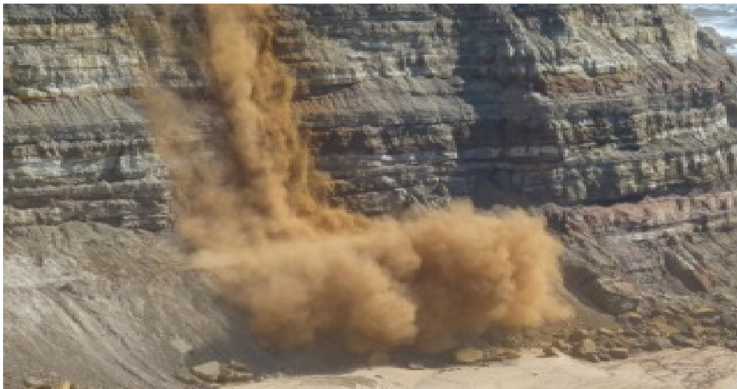
Estabilização da Escarpa da Praia da Calada
