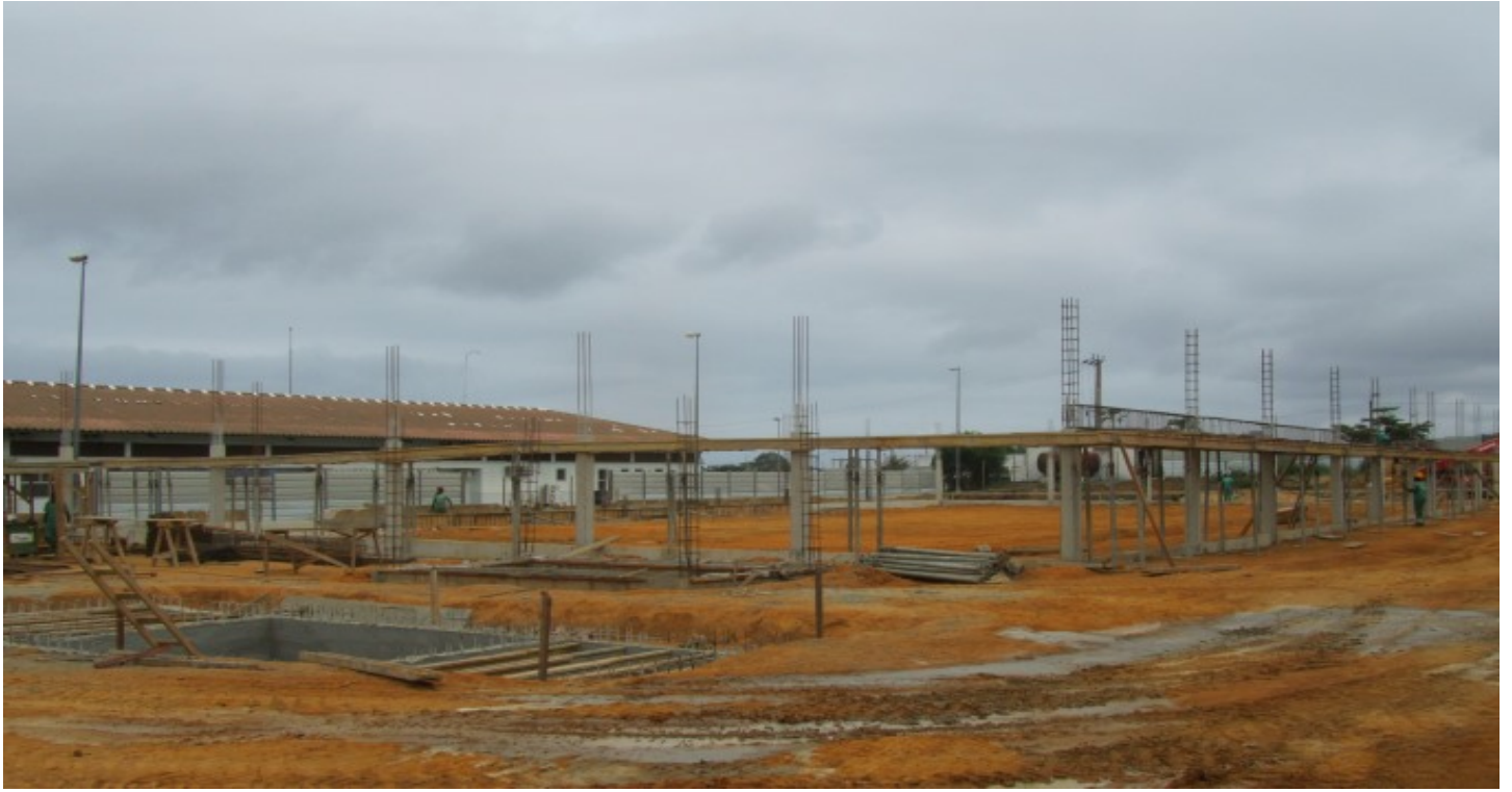
Clínica de Hemodiálise de Cabinda (Edifer Angola)
