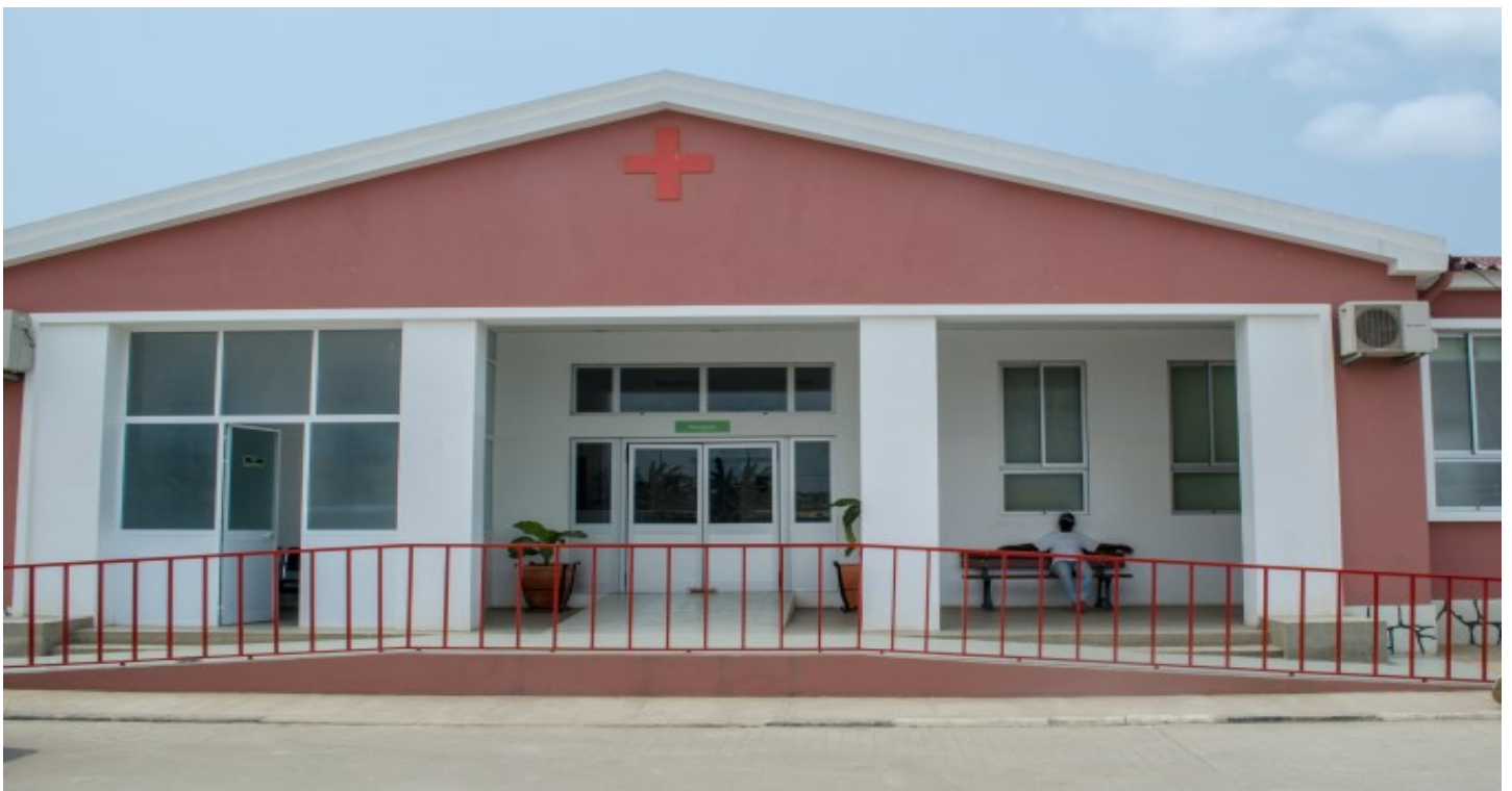
Reabilitação do Hospital do Bengo (Edifer Angola)
