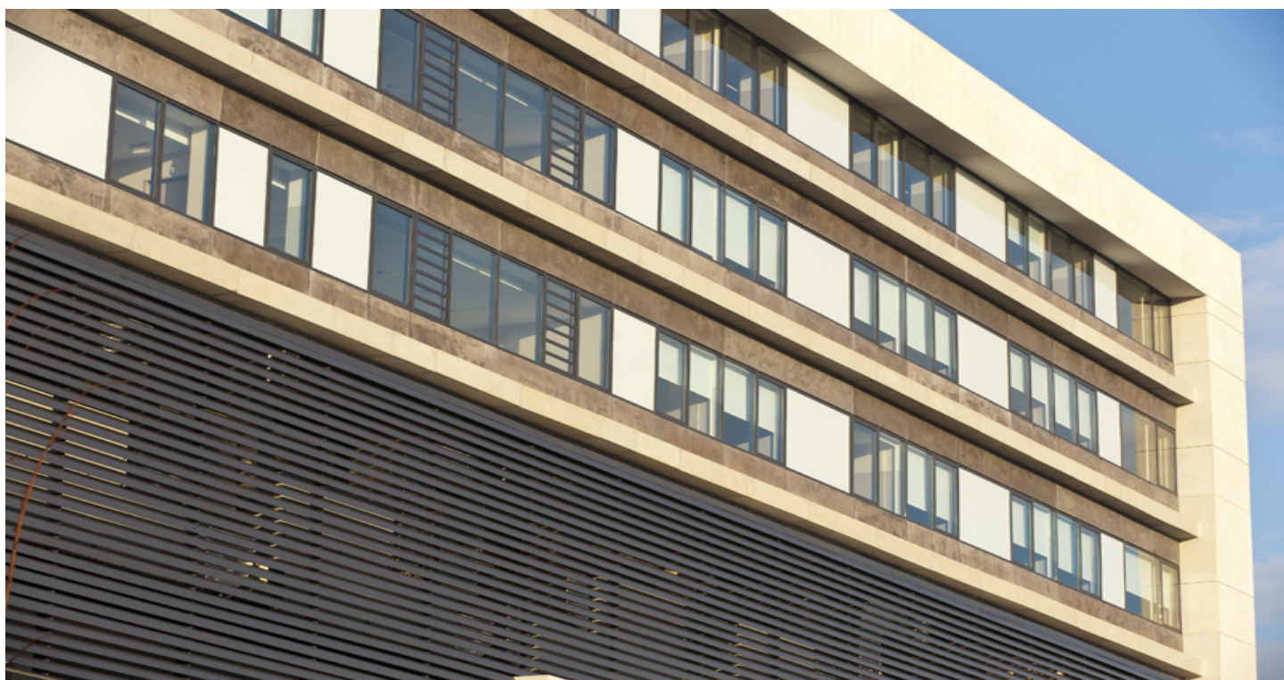
Hospital Privado Alfena
