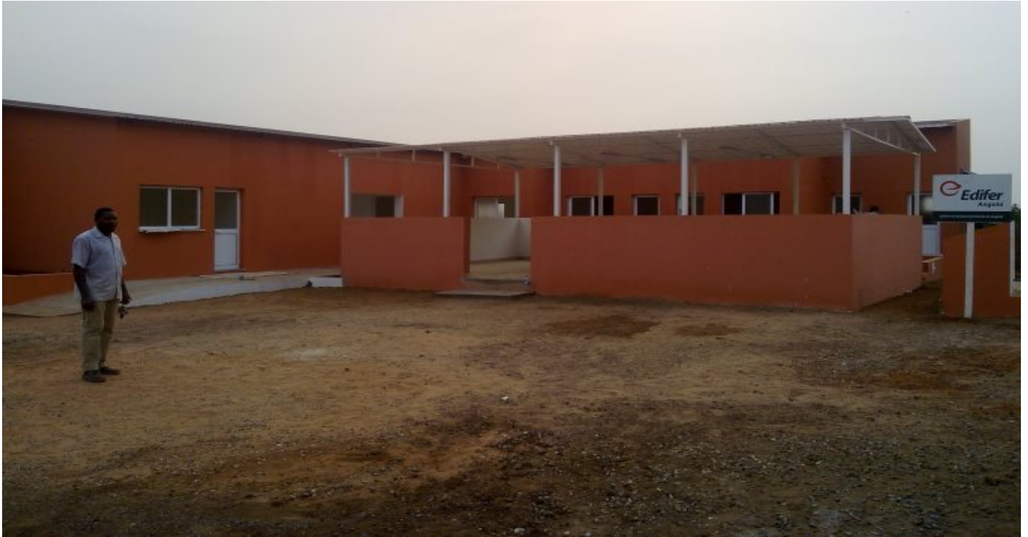
Centro de Saúde em Malange (Edifer Angola)
