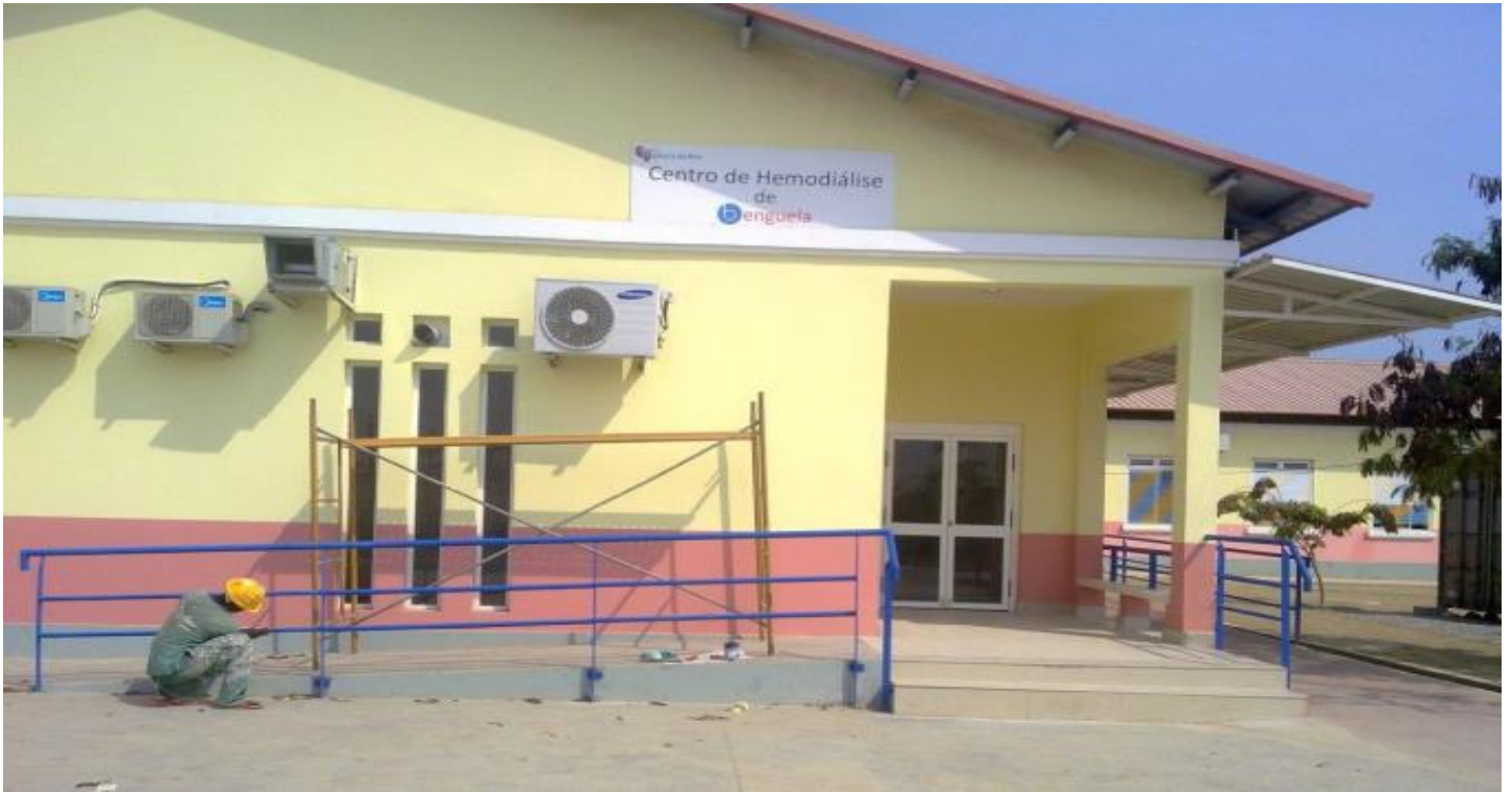
Clínica de Hemodiálise de Benguela (Edifer Angola)
