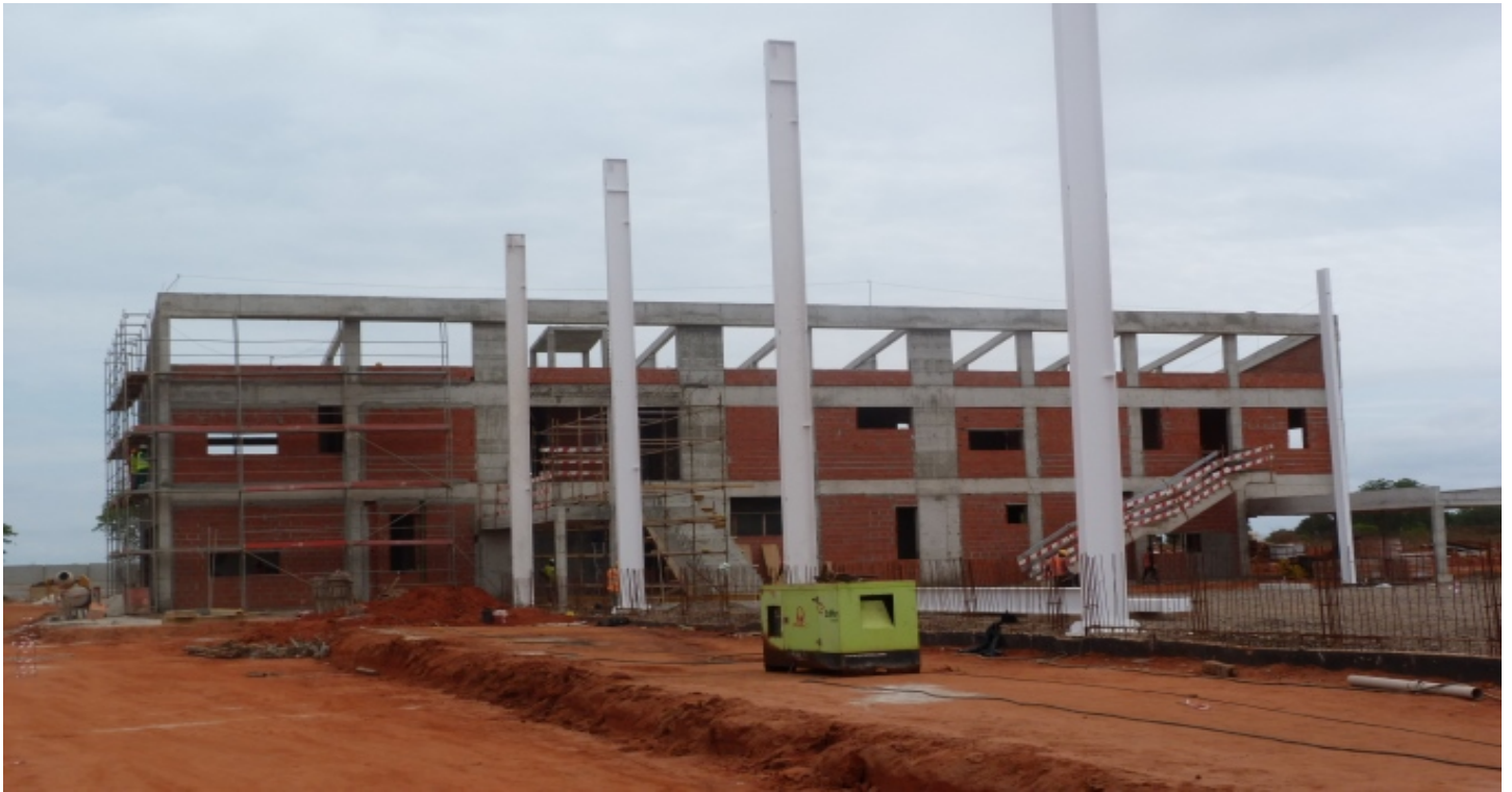
Armazém de Medicamentos (Edifer Angola)
