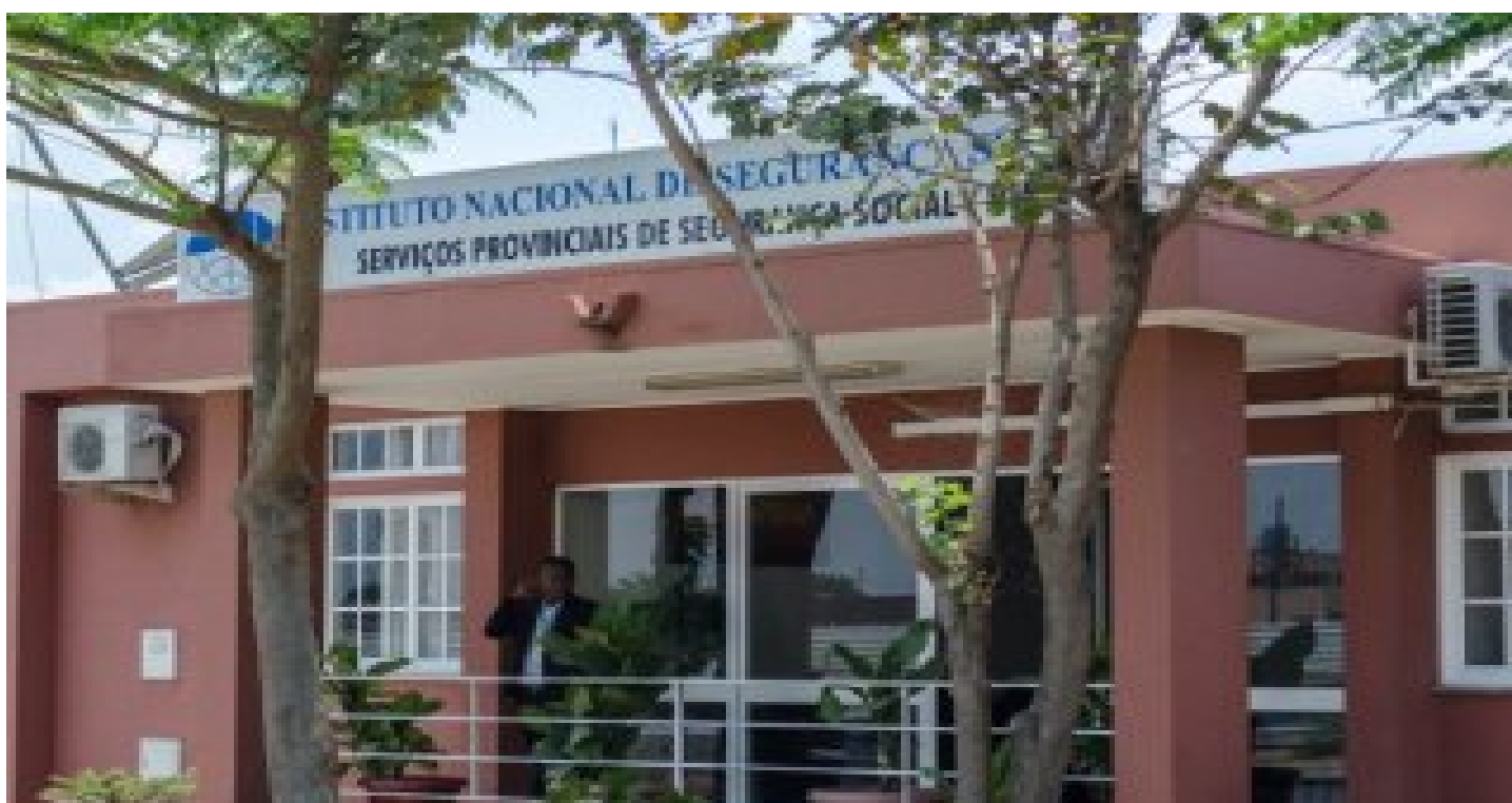
Edifícios Provinciais do MAPESS e INSS
