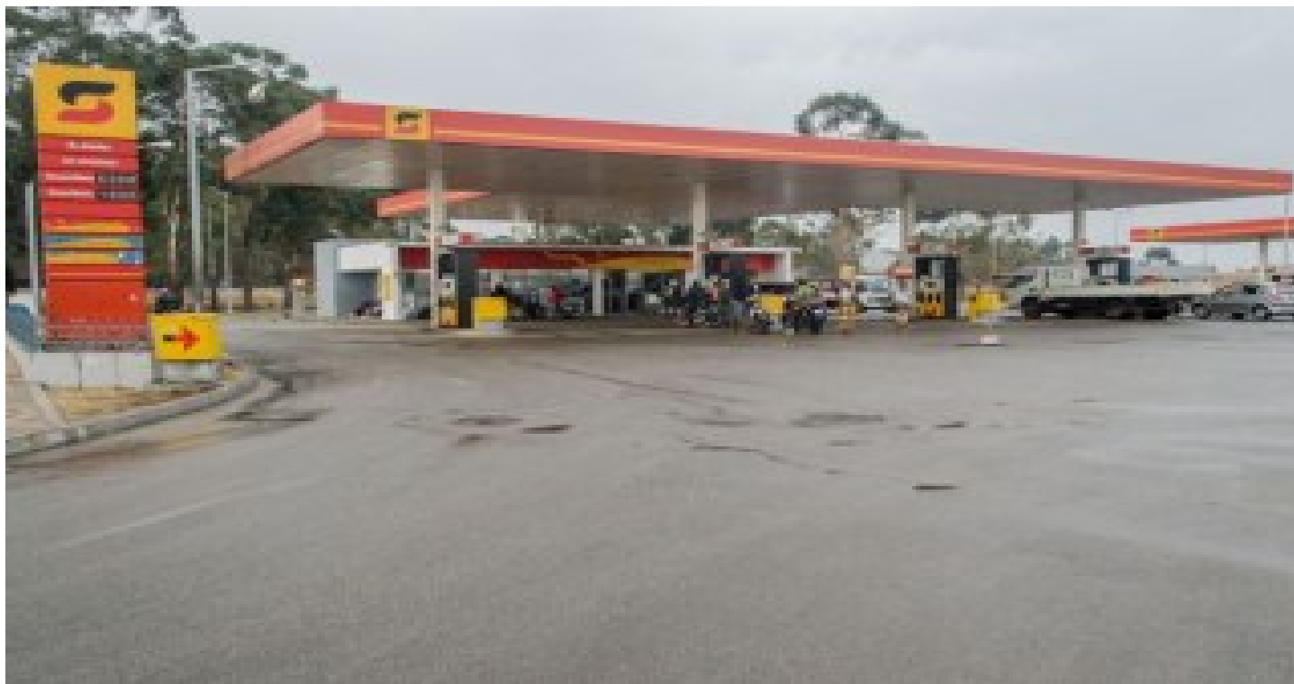
Posto de Abastecimento CAPANGO
