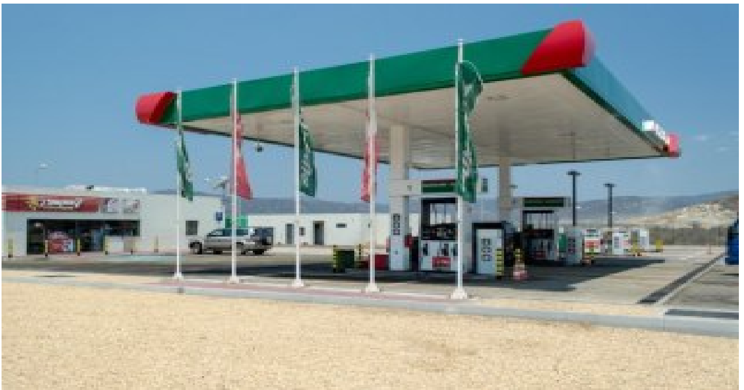
Posto de Abastecimento Colango PUMANGOL
