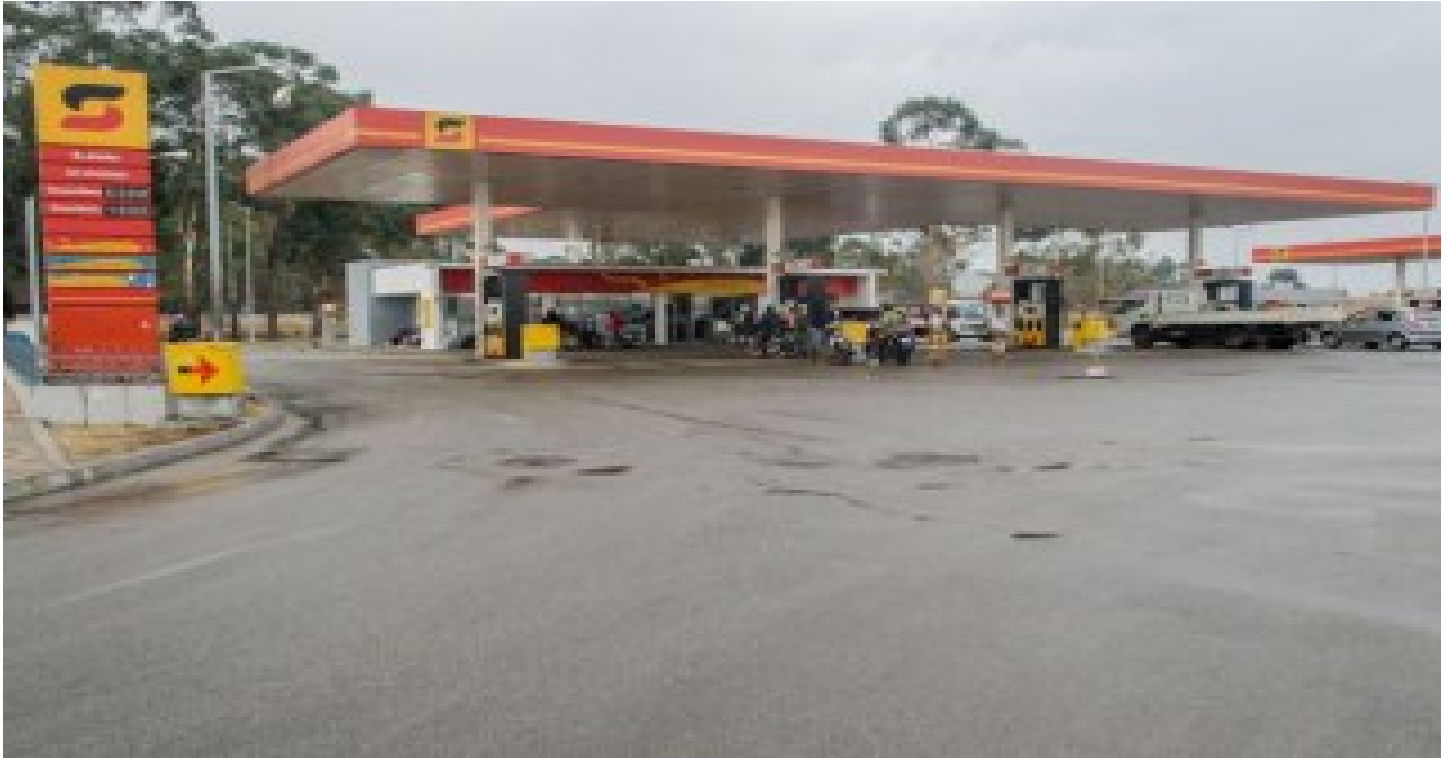
Posto de Abastecimento CAPANGO
