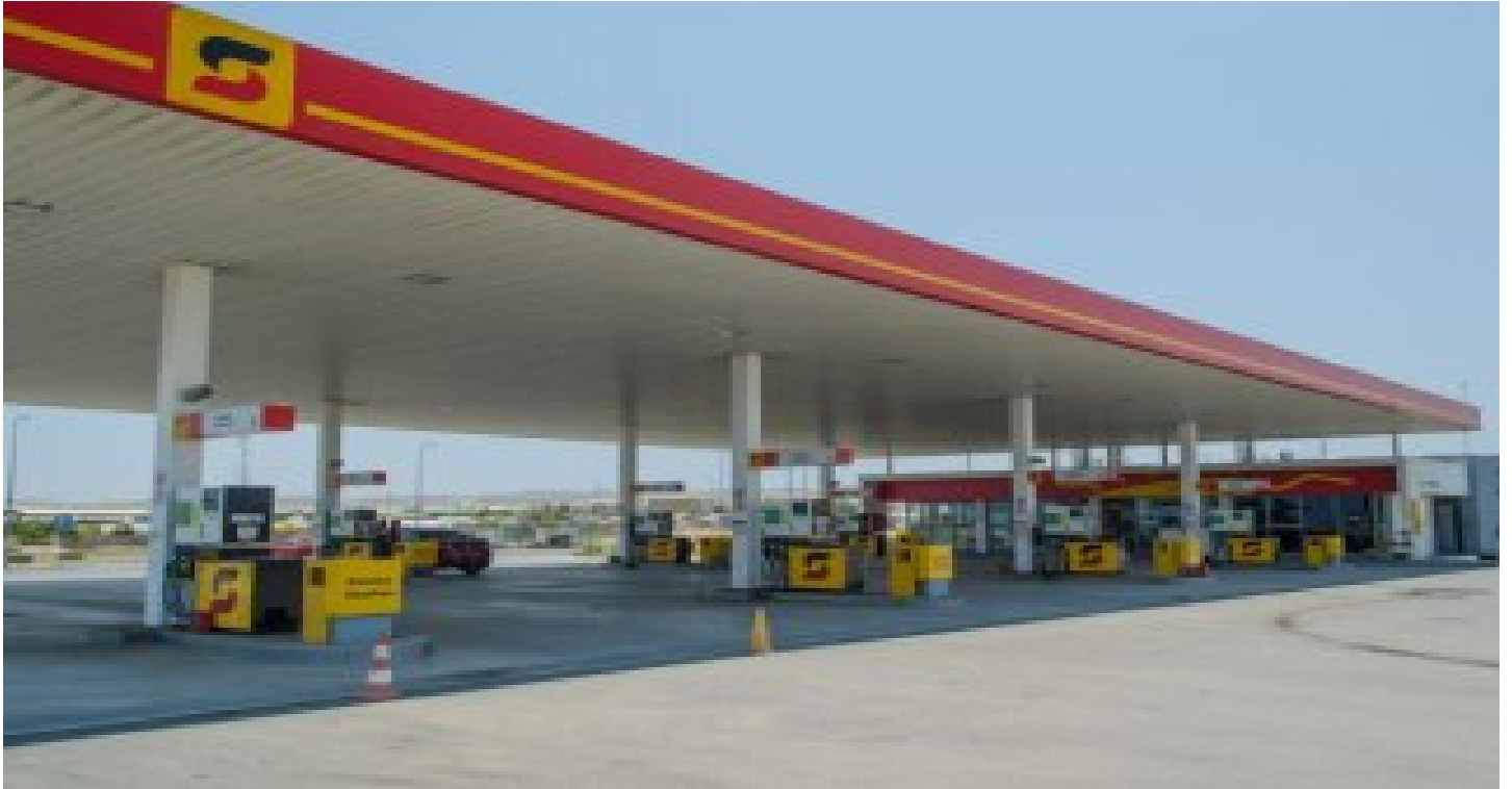
Posto de Abastecimento da Catumbela
