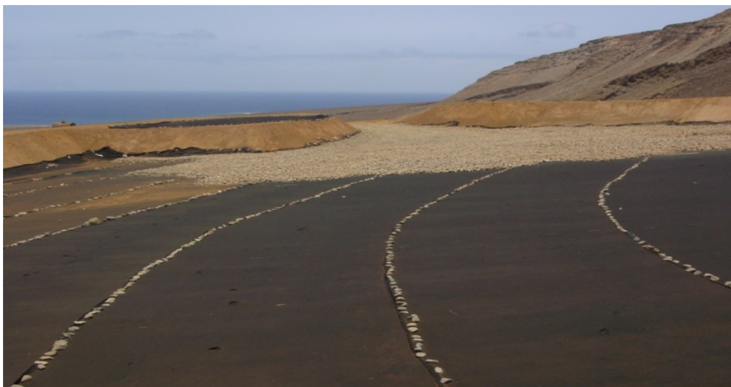
Construção de 2 aterros do Município de S. Nicolau
