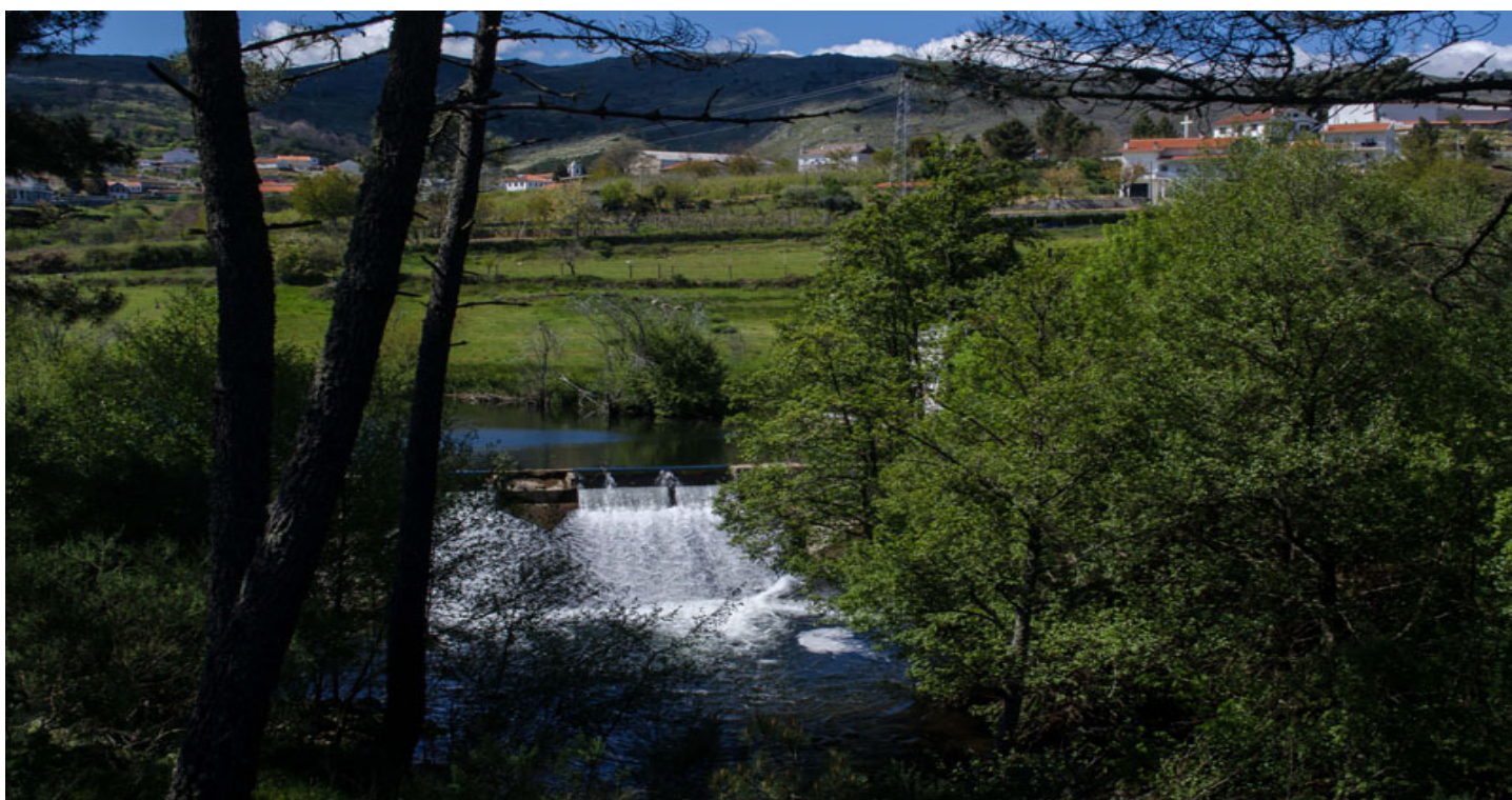
Adutoras e Reservatórios de Água do Subsistema de Balsemão
