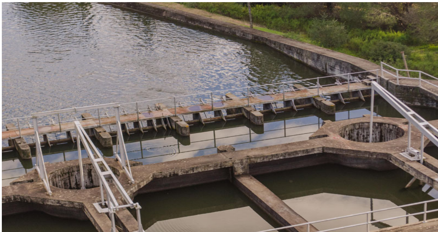
Albufeira de Odivelas Segregação de Caudais
